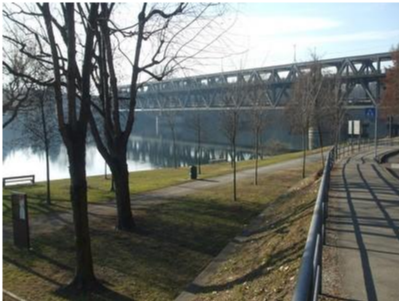
Sesto Calende – Ponte in ferro sul fiume Ticino
